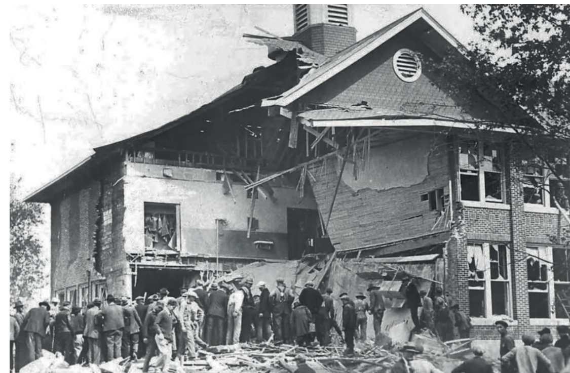
Рис. 2. Здание школы «Бат» после взрыва, 1927 г.
